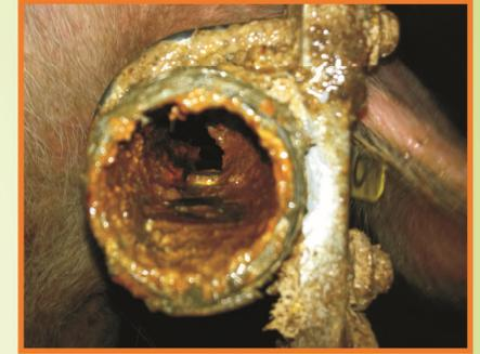
Estado de una tubería de agua en una explotación de cerdos
